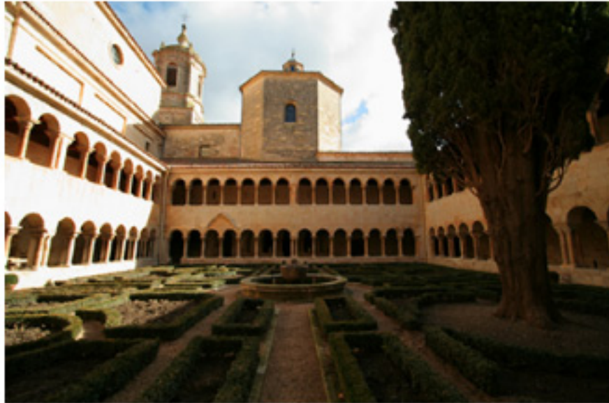
El claustro románico de Santo Domingo de Silos
